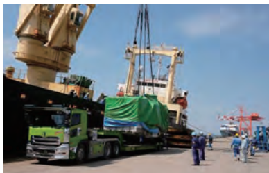
特別高圧変圧器 輸入の様子
